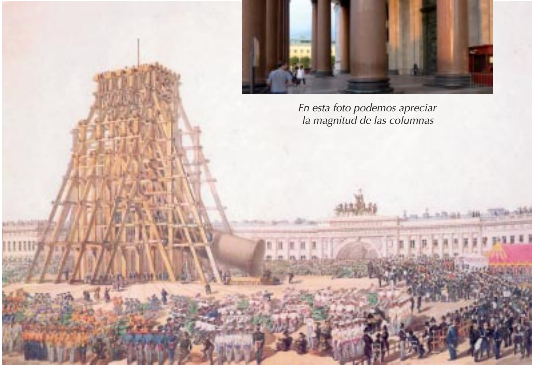
Columna de Alejandro en construcción
