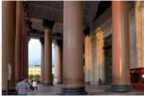
En esta foto podemos apreciar la magnitud de las columnas
