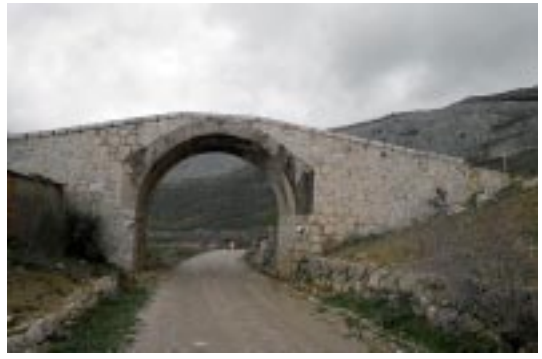
Puente de El Aguadero
