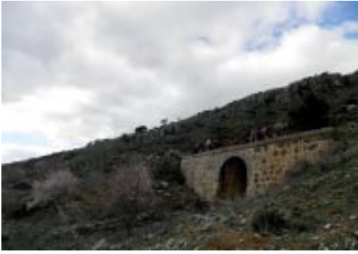
Puente de mampostería en la traza del ferrocarril, próximo a Carrión
